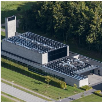
Fælleskrematoriet med solcelleanlæg
